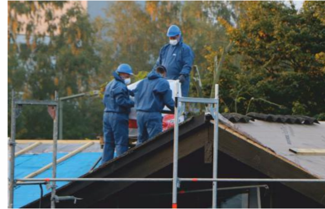
Asbest-Rückbau - eine verantwortungsvolle Aufgabe.
